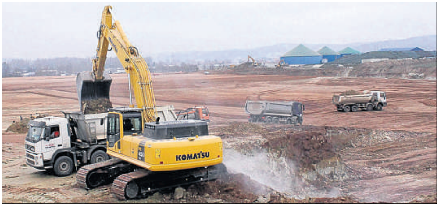
Großbaustelle: Von früh bis spät rollen die Bagger auf dem Areal in Nachbarschaft zur Biogasanlage. 200 000 Kubikmeter Erde wurden hier in den vergangenen Wochen ausgehoben. Ende November werden dann die ersten Stützen für die Halle geliefert. Fotos: Lerner
