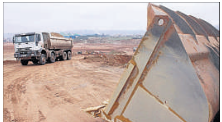
Massen: Bis zu 800 Lkw-Ladungen Erde am Tag wurden von der Baustelle hinüber in die ehemalige Sandgrube Funke verbracht.
