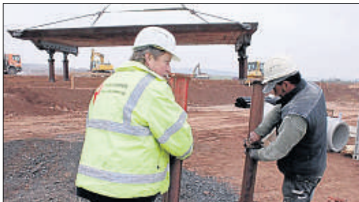
Maßarbeit: Für den Aushub des Regenrückhaltebeckens und die Kanalarbeiten nördlich der Gleise ist die Firma Pieper zuständig.
