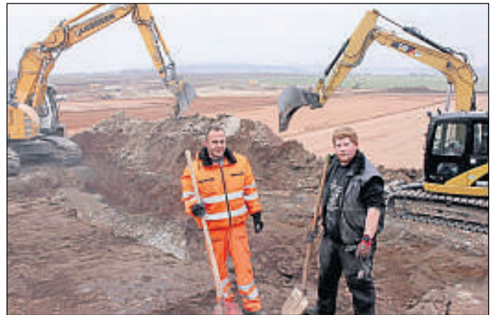
Mit Schaufel und Bagger: Seit Ende September laufen die Arbeiten auf der 100 000 Quadratmeter großen Fläche, auf der die Logistikhalle (50 000 Quadratmeter) entstehen soll.
